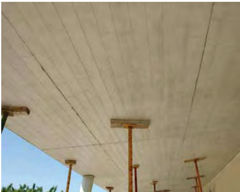
Acabado en hormigón. /Concrete finish.
