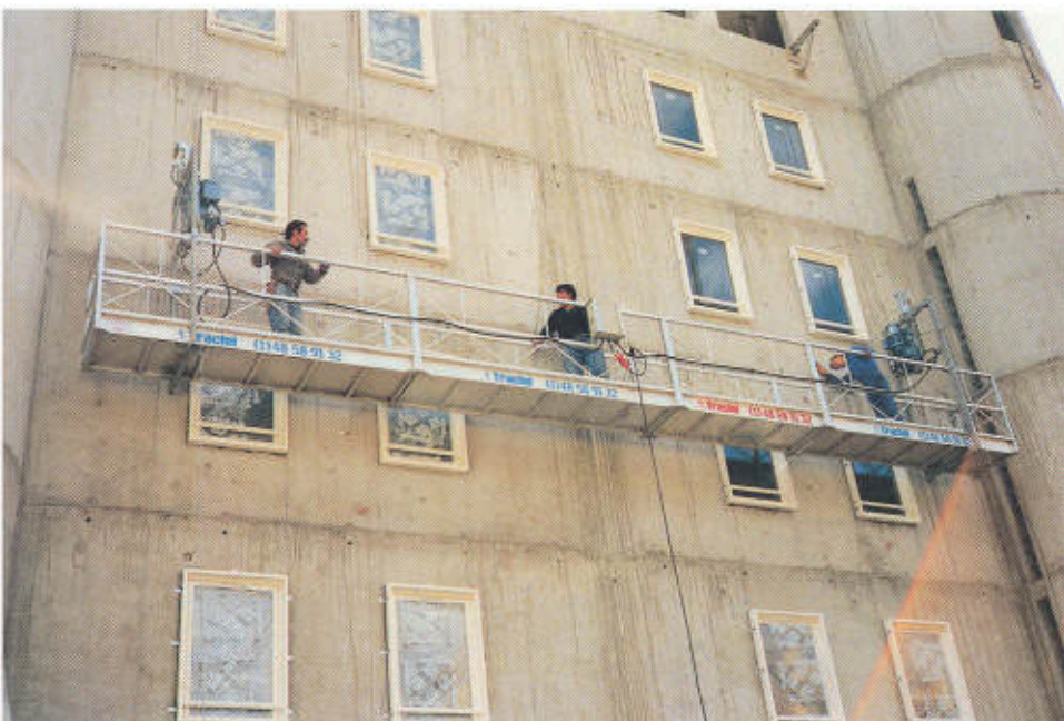
Andamio de 2 m. con liras extremas Andamio modular de 11 m. con liras en cuadro
