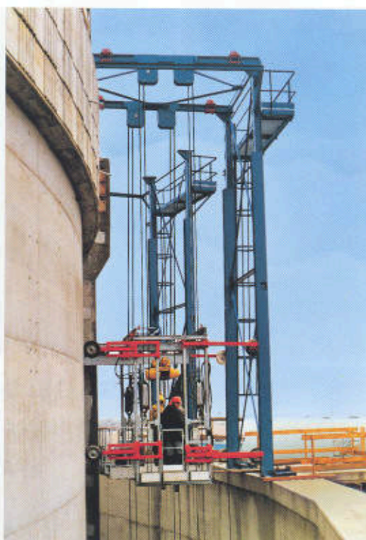
plataformas de postensado equipada con aparatos hidráulicos TIRFOR TU-32H
