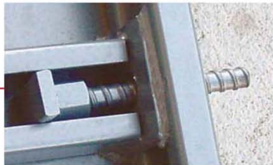
Barra Diwidag Ø13 integrada como parte del panel Incorporated diwidag Ø13, part of the panel
