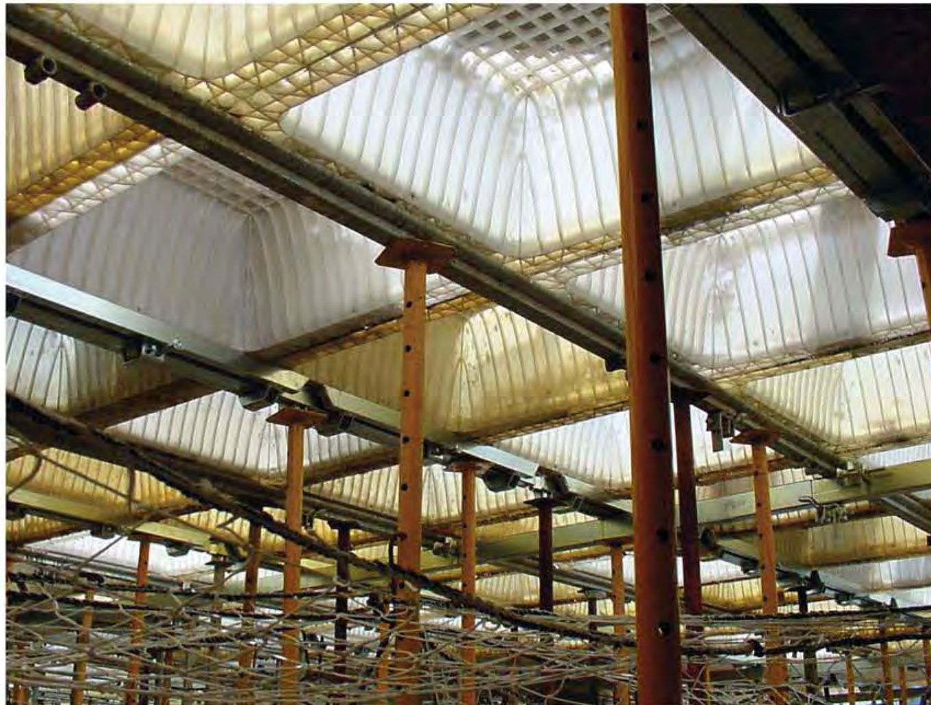
SOPANDEO/PARTIAL RECOVERY/ÉTAYER APRÈS QUITTER LE COFFRAGE ABSTÜTZUNG NACH DEM FRÜHAUSSCHALEN/APPUNTALLAMENTO PARZIALE
