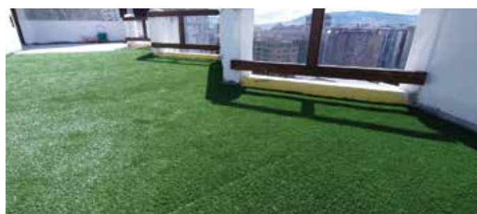
3. Directamente colocar el césped artificial, realizando las juntas del mismo con lámina JOINT .
