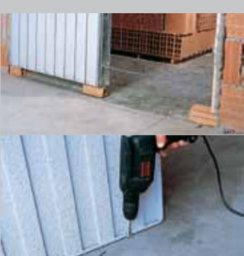
5a. Fijación sobre pavimento por terminar. 5b. Fijación sobre un pavimento terminado.
