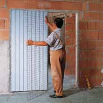
6. Después de rejuntar el armazón y el tabique con cemento, colocar la red metálica.
