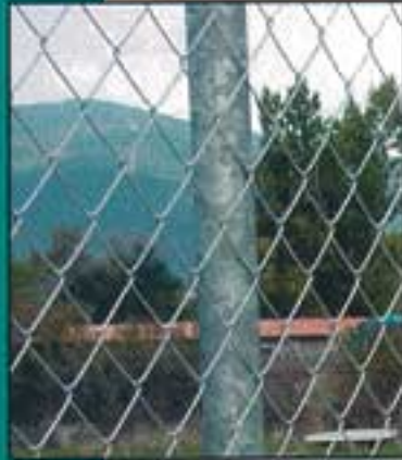
3.1 CERRAMIENTOS MALLA SIMPLE TORSIÓN.
