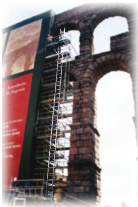
Maxial Super Kwik MA 445 de 22 m equipado para montaje de andamios
