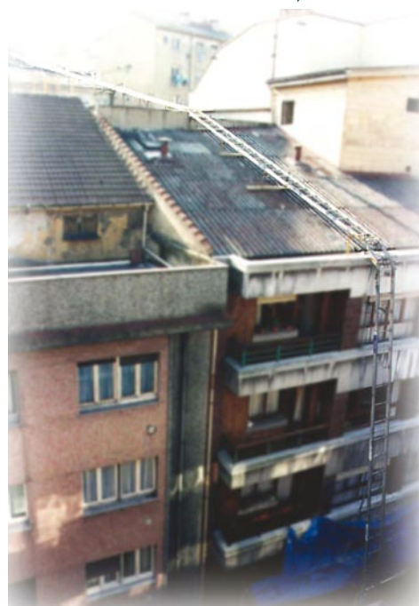
Maxial Super Kwik MA 445 de 65 m equipado con dos codos regulables y caballetes
