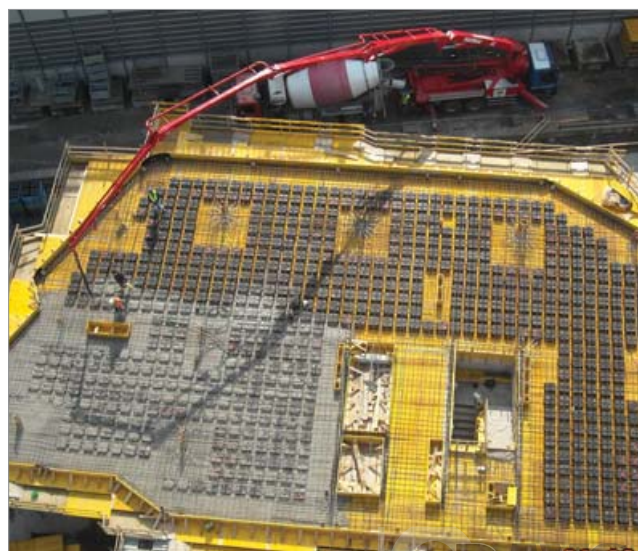
Edificio para uso industrial
