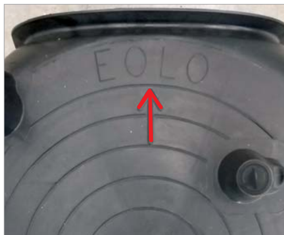
Fig. 1 - Colocación en seco del primer encofrado, la flecha está dirigida hacia el cordón de fundación.
