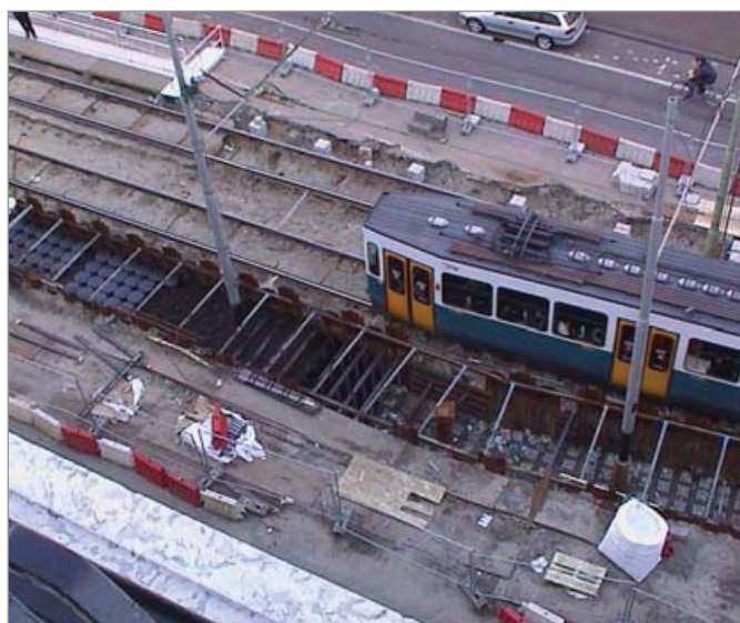
Reforma de andén del Metro
