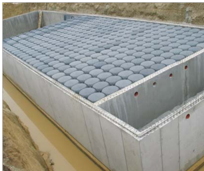
Cisterna de recogida agua debajo de una zona industrial
