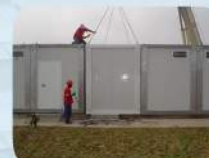
Acoplamiento de Módulos Modules Assembly
