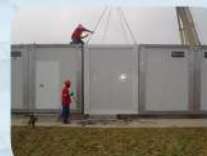
Acoplamiento de Módulos Modules Assembly
