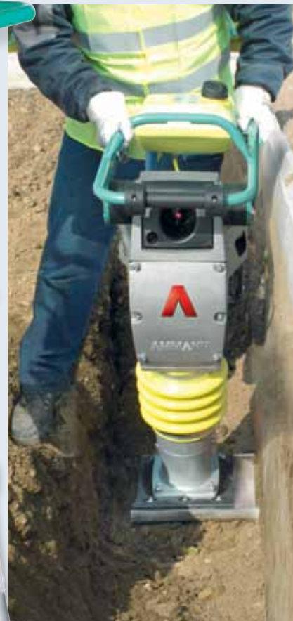
Asimétrico 310mm: trabajo de compactación en zanjas protegido por sistemas de
