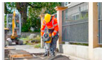
Tecnología de demolición y corte
