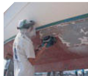
Trabajos de mantenimiento en astilleros.
