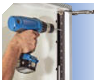
Taladrado para la colocación de estantes.
