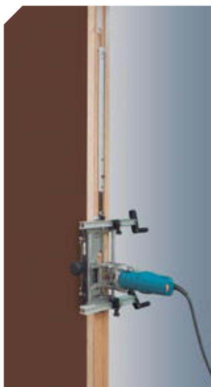
Realización del segundo encaje en el marco.
