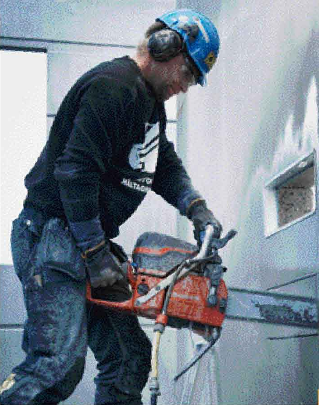
Al cortar las esquinas primero con la K 970 Chain, pueden ser realizados exactamente en la posición correcta.
