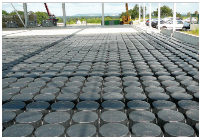
Espacio ventilado para construcción para uso industrial
