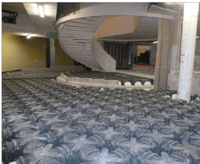
Restauración de edificio histórico
