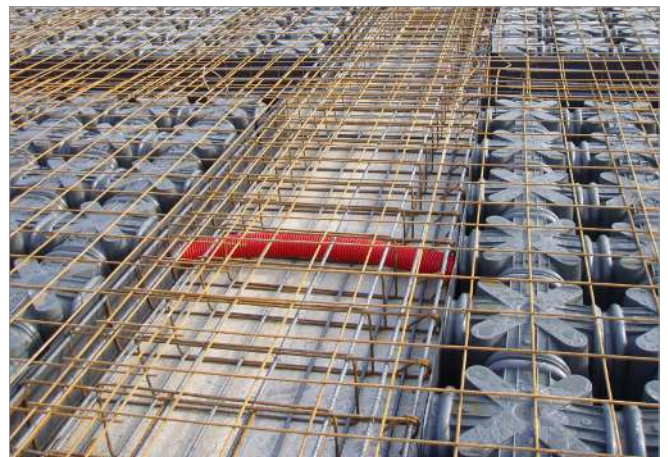
Edificio para uso residencial
