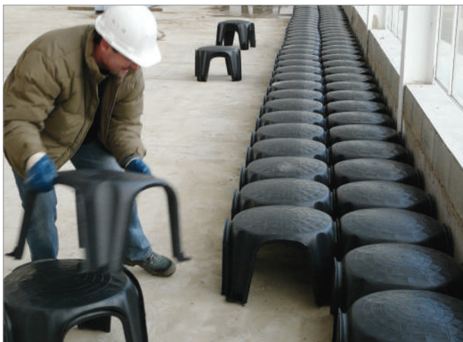
Fig. 3 - Detalle de la fase de encaje del sistema macho-hembra - A destacar el sellado perfecto del pie.
