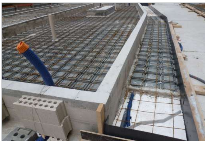
Rampa de entrada
