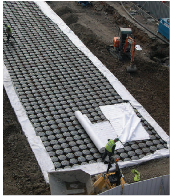
Cisterna de recogida de agua
