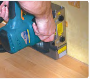
Corte de la junta de dilatación.
