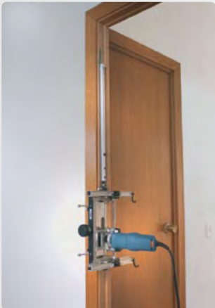
Realización del segundo encaje en el marco.
