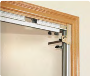
Colocación de los tapajuntas utilizando como guía los topes dispuestos al efecto.
