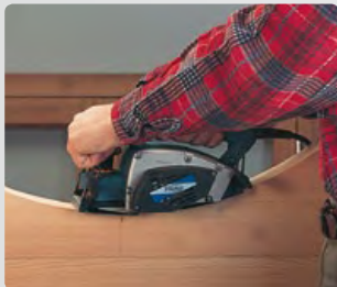
Cepillado de superficies cóncavas.
