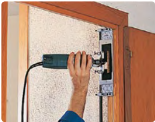
Colocación en el marco (Mod. A093)
