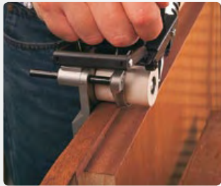
Aplacado de la cara superior del solape.
