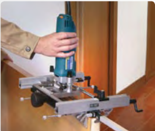
Realización del primer encaje en la puerta.
