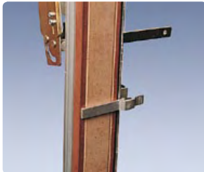
Fijación de los cercos a la plantilla.
