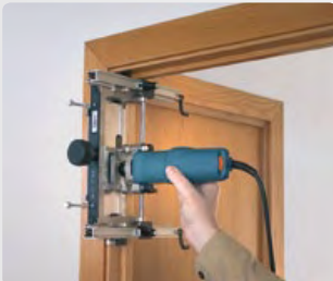
Realización del encaje superior en el marco.
