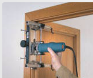
Realización del encaje superior en el marco.
