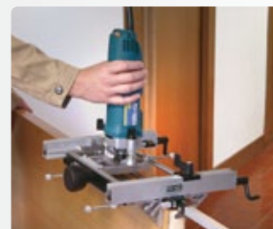
Realización del primer encaje en la puerta.
