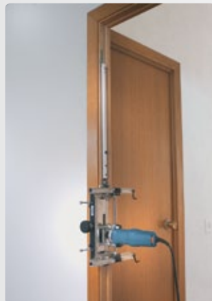
Realización del segundo encaje en el marco.
