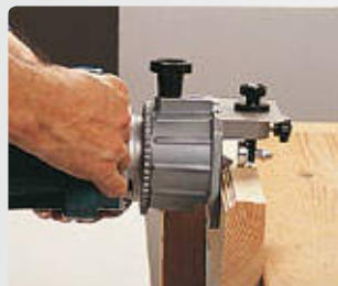
Realización de molduras.
