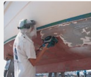
Trabajos de mantenimiento en astilleros.
