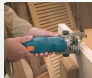
Realización de molduras.
