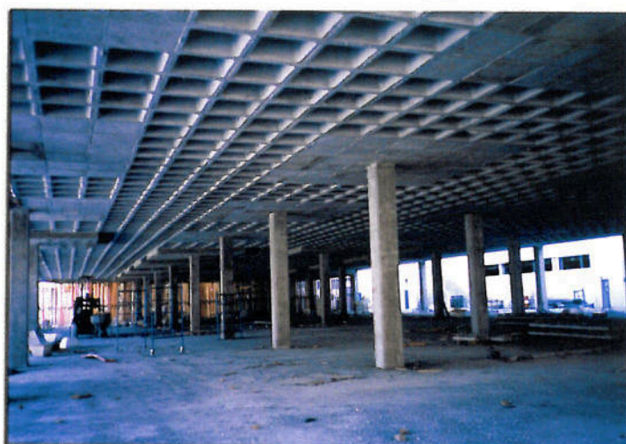
Obra Centro Comercial Las Cañadas (Marbella)
