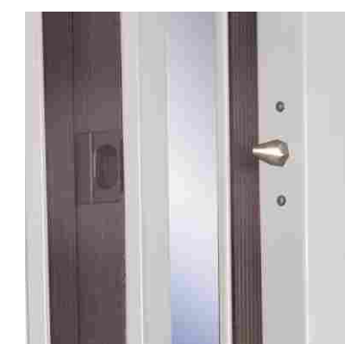
intumescent seal uszczelka pęczniąca
