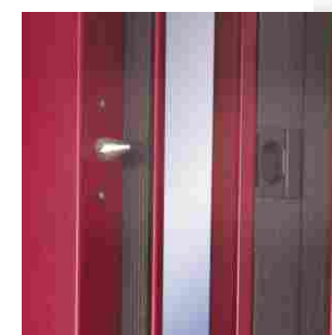
anti-crowbar device boleć antywyważeniowy
