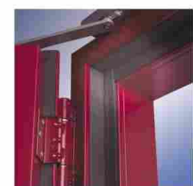
intumescent seal for frame uszczelka pęczniejąca ościeżnicy
