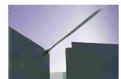
selector regulator kolejności zamykania
