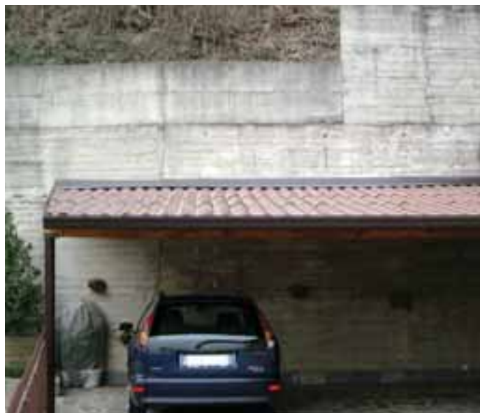
Cobertizo realizado con guttascudo® curva antiguo
