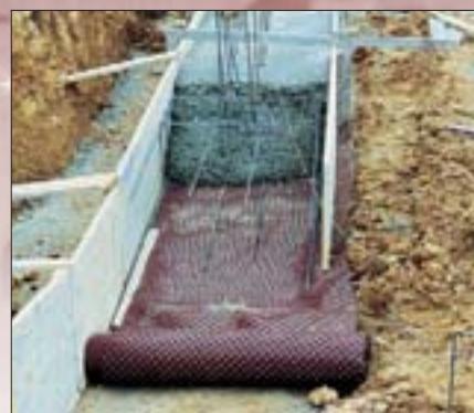
Colocación de Guttabeta® Star en sustitución de la capa de hormigón.
