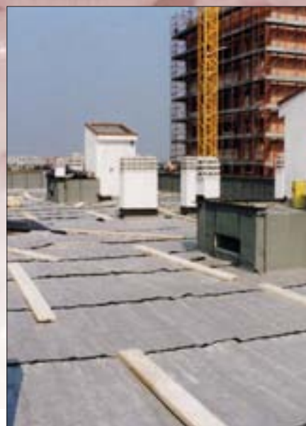
guttabeta® drain como capa drenante e impermeabilizante en una terraza ajardinada.
