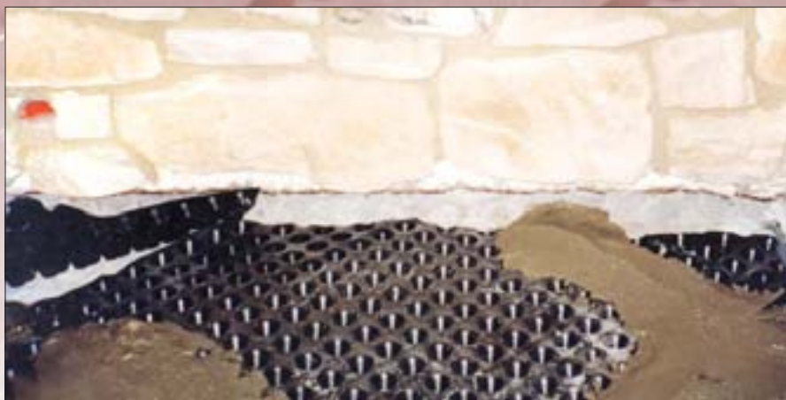
Con guttabeta® T20 se crea una microcámara de aire contra la humedad por capilaridad.
