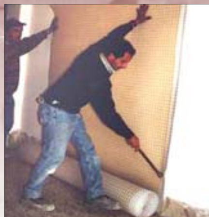
guttabeta® PT permite tener enlucidos secos, ideal para los locales en contacto con el terreno.
