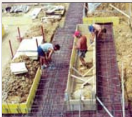
Colocación de guttabeta® Star en sustitución de la capa de hormigón.
