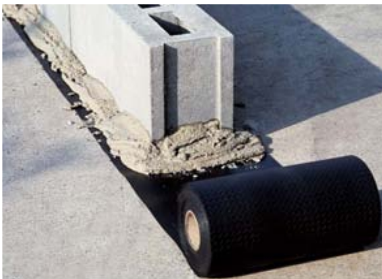
Colocación de guttabau® KMS
