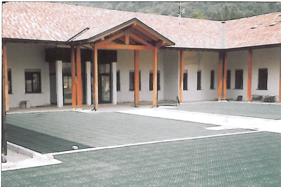
Colocación de guttagarden® en zonas vehiculares y peatonales Laying of guttagarden® in pedestrian and vehicular zones
