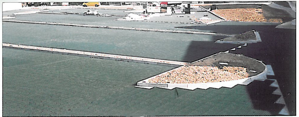
Fig. 4 Pose des dalles à proximité des poutres de bordure. Laying the paving near kerbs
