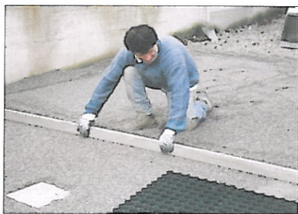
Fig. 2 Nivelación y preparación del fondo Levelling and foundation preparation
