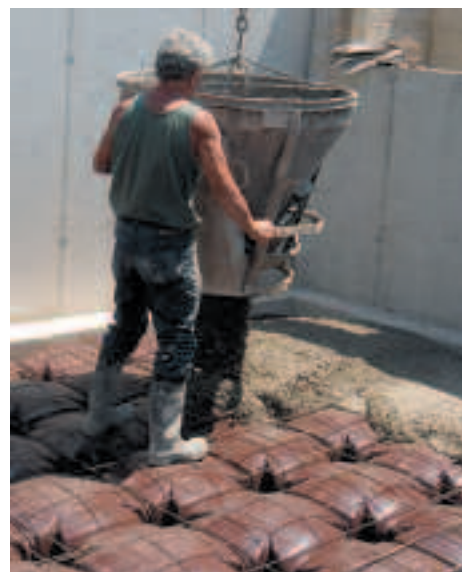
Foto 3 - Colada primer forjado
