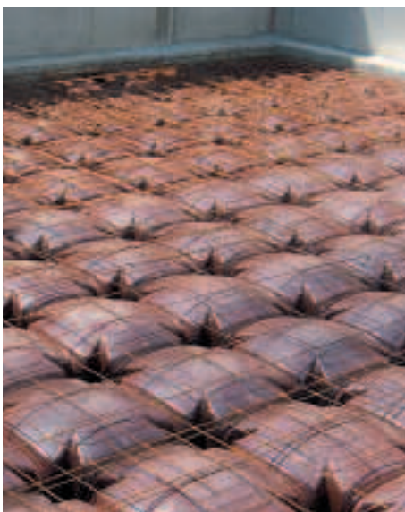
Foto 2 - Colocación Guttadrytek®
