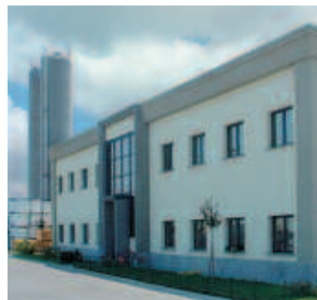
Establecimiento de Stradella (PV)
