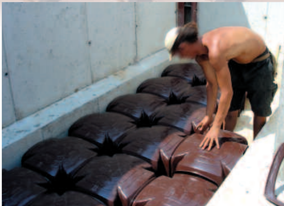
Foto 1 - Colocación Guttadrytek®
