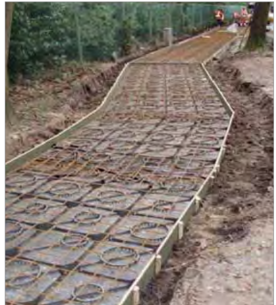
Cámara para pista de bicicletas con función protectora de raíces
