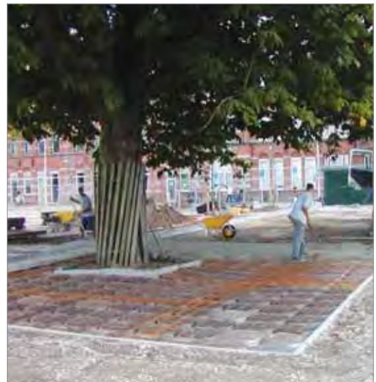
Cámara con función protectora de raíces
