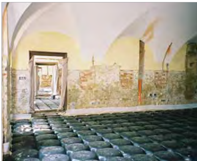
Restauración de edificio histórico
