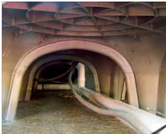
Ejemplo de paso de instalaciones
