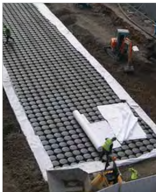
Cisterna de recogida de agua
