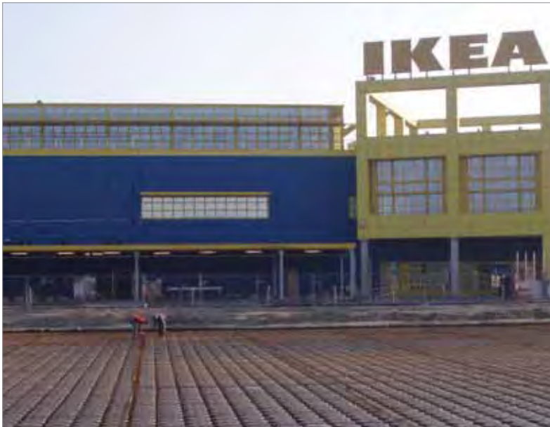
Cistema de dispersión debajo de un aparcamiento comercial
