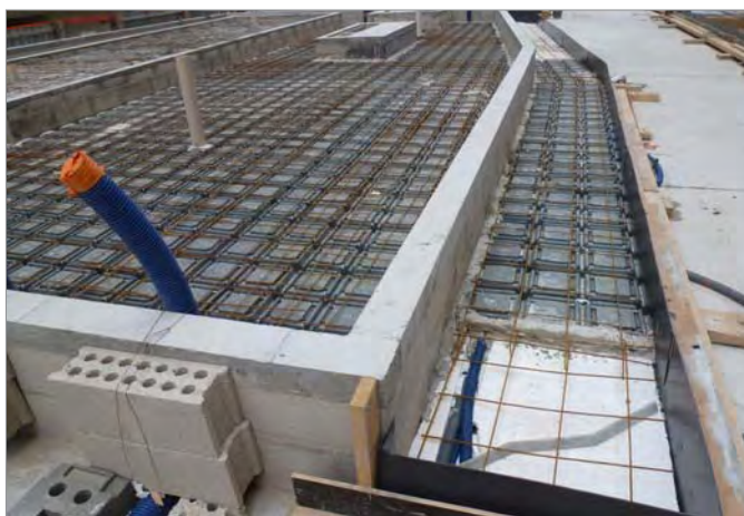
Rampas de acceso
