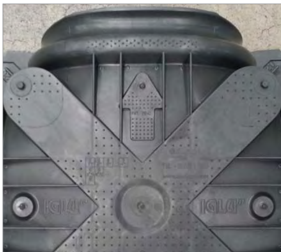
Fig. 1 - Colocación en seco del primer encofrado, la flecha está dirigida hacia el cordón de fundación.
