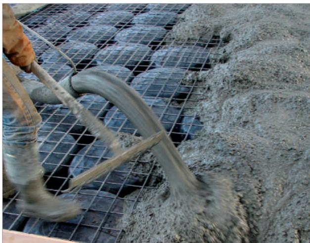
Los encofrados modulares de plástico Iglù®, arriados en secuencia según un orden predeterminado, permiten formar rápidamente una plataforma para peatones autoportante encima de la cual se realiza una colada de hormigón para constituir, de una manera muy simple y barata, un forjado ventilado que se apoya sobre pilarotes con la zona debajo hueca utilizable para hacer pasar tuberías y cables pero sobre todo ventilada para hacer frente a la humedad de remonte y a los gases radiactivos.
