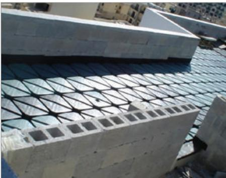
Un tema que en los últimos años ha cobrado siempre mayor importancia es el excesivo consumo de energía de los edificios, consumo que se puede reducir de manera notable mediante una variante inteligente del uso de los Iglú®: la ventilación del techo. Colocando en la cubierta horizontal del edificio los encofrados Iglú® se crea una cámara de aire que permite aislar de la calor en verano y del frío en invierno, con consiguiente ahorro a la hora de climatizar los espacios internos.
