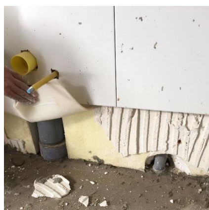
Fig. 35: Conducciones de saneamiento introducidas en el panel.
