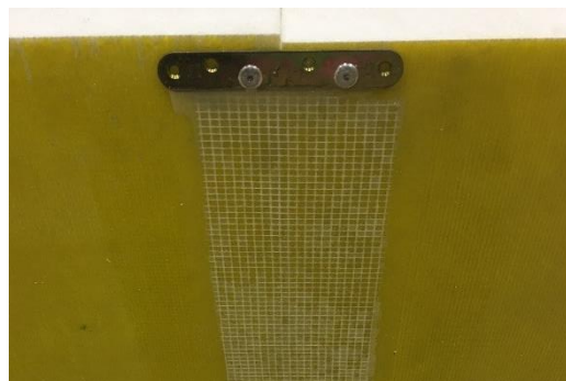
Fig. 31: Fijación provisional mediante pletinas metálicas.
