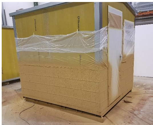
Fig. 17: Imagen de la proyección in situ de corcho natural.
