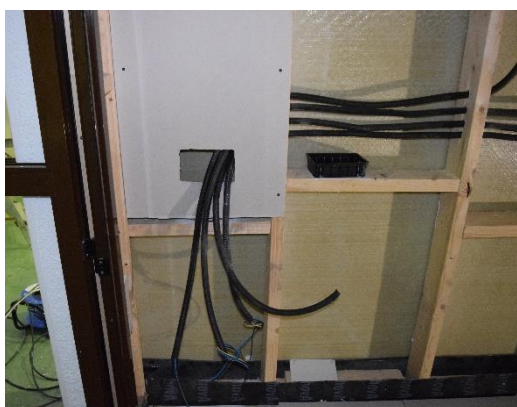
Fig. 32: Conducciones introducidas en estructura auxiliar de madera.
