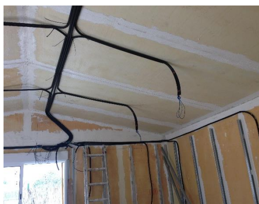
Fig. 33: Conducciones introducidas en estructura auxiliar metálica.
