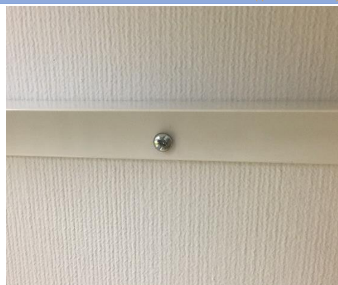
Fig. 12: Elemento fijado al panel mediante remaches expansivos.
