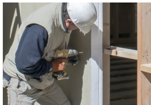
Fig. 4: Fijación mecánica de panel vertical a estructura de madera.
