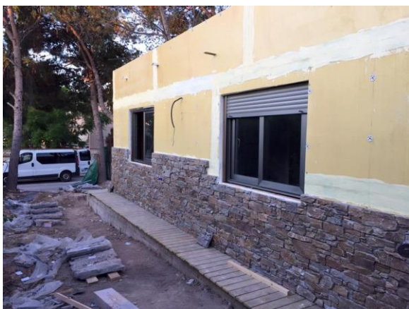
Fig. 19: Imagen de la ejecución de un aplacado de piedra.
