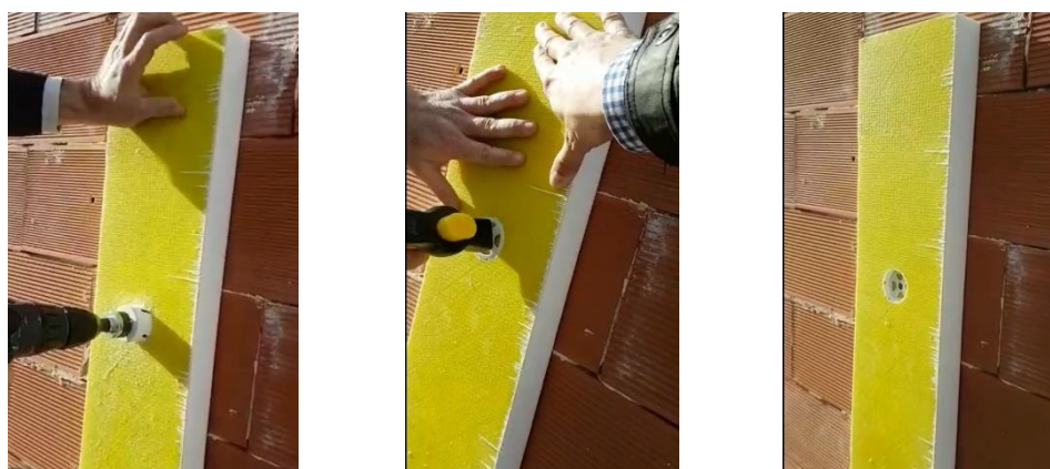
Fig. 5: Secuencia de fijación oculta de un panel a una fábrica de ladrillo.
