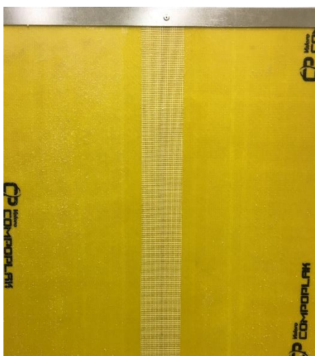
Fig. 27: Unión de los paneles mediante soldadura química (malla de fibra de vidrio + resina de poliéster).
