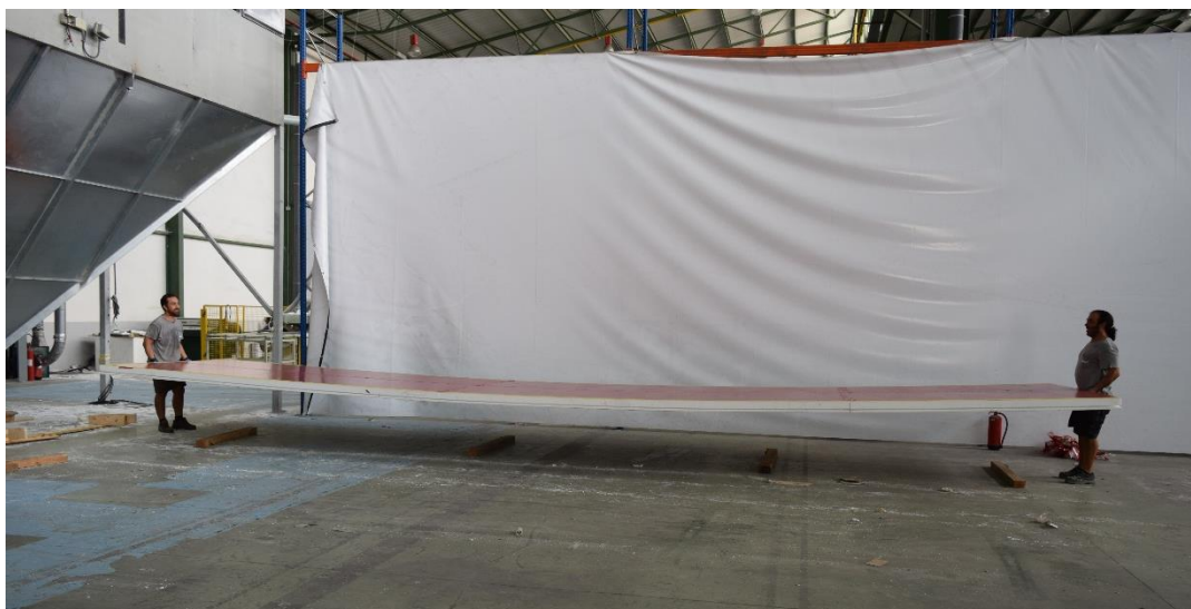
Fig. 36: Manipulación de un panel de grandes dimensiones (12,00 x 2,40 x 0,10) m por dos operarios.
