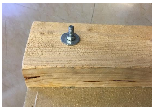
Fig. 7: Panel fijado mediante tornillo pasante a viga de madera.
