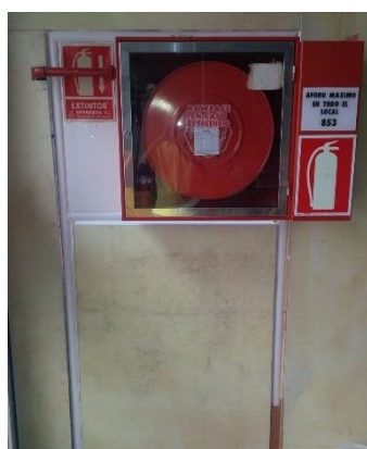
Fig. 34: Conducciones de instalación frente a incendios introducidas en el panel.
