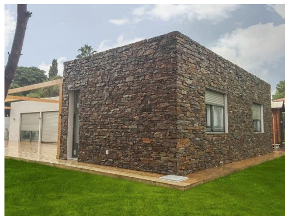
Fig. 20: Ejemplo de revestimiento exterior de aplacado de piedra.
