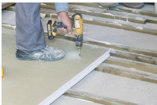
Fig. 3: Fijación mecánica de panel horizontal a estructura de madera.
