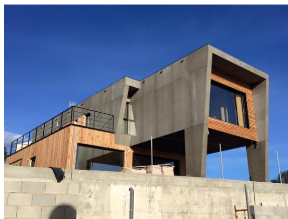
Fig. 22: Ejemplo de revestimiento exterior de paneles de madera-cemento (Viroc).
