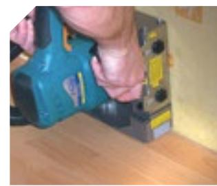
Corte de la junta de dilatación.
