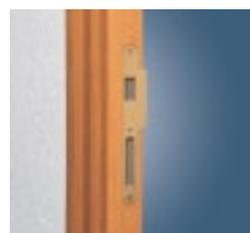
Con el UC16K y la FR66P es posible realizar el encaje para la armella o cerradero y los orificios del picaporte y palanca.
