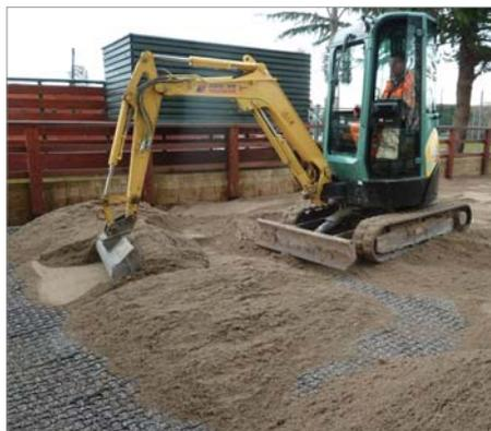
**1 REALIZACIÓN DE UNA CAPA PERMEABLE** (grava de grano variable 3-10 mm) de unos 15-20 cm. Eventual capa de arena silícea oportunamente nivelada de aprox. 4 cm. Colocación del geotextido antes del desarrollo de la pavimentación.
