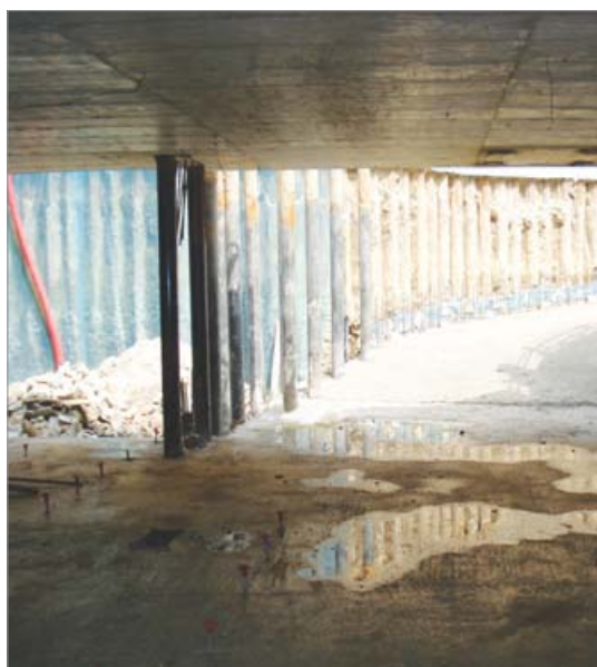
Ejemplo de aplicación: aparcamiento subterráneo con técnica 'top-down'.
