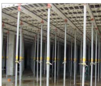
Detalles fotográficos de la secuencia completa de colocación del entablado, colocación de U-Boot Beton ® , armadura de la estructura a realizar en la obra, colada y alisado final.
