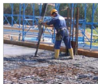
Detalles fotográficos de la secuencia completa de colocación del entablado, colocación de U-Boot Beton ® , armadura de la estructura a realizar en la obra, colada y alisado final.
