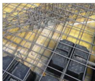
Detalles fotográficos de la secuencia completa de colocación del entablado, colocación de U-Boot Beton ® , armadura de la estructura a realizar en la obra, colada y alisado final.
