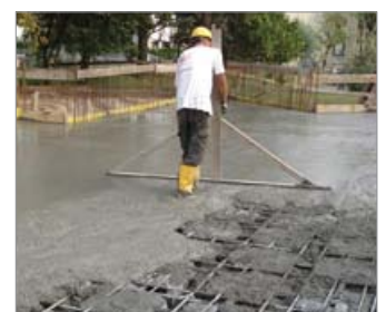
Detalles fotográficos de la secuencia completa de colocación del entablado, colocación de U-Boot Beton ® , armadura de la estructura a realizar en la obra, colada y alisado final.
