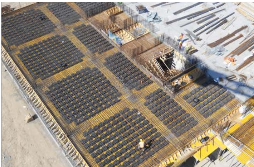
Edificio para uso industrial
