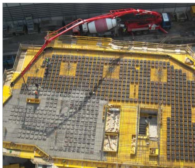
Edificio para uso industrial
