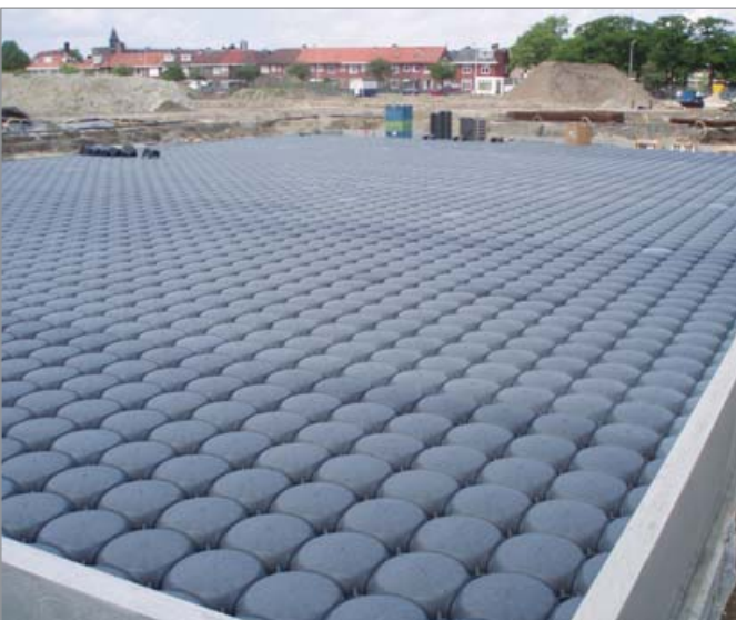
Cisterna de recogida debajo de una zona industrial
