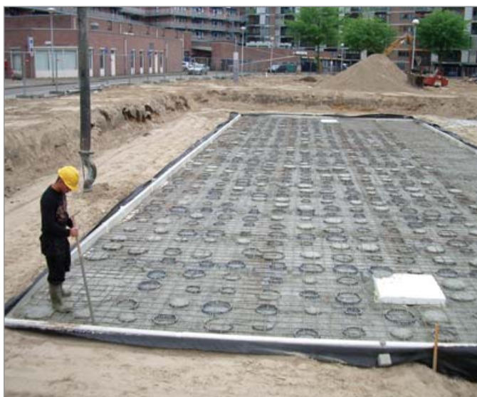
Cisterna de dispersión debajo de un aparcamiento
