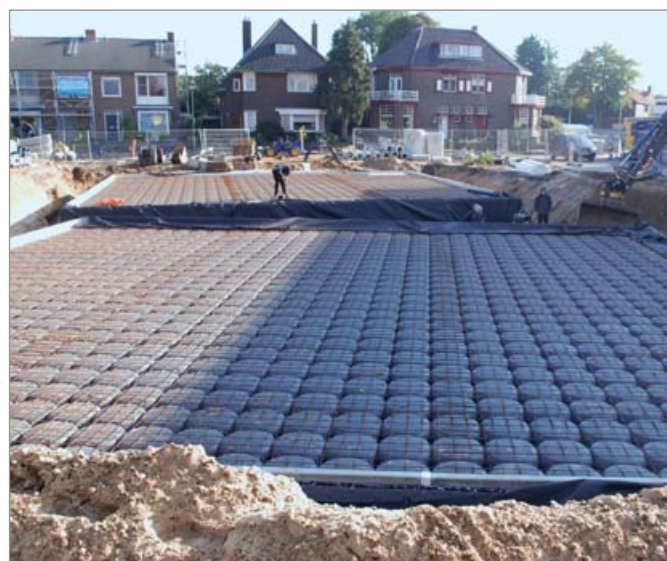
Cisterna de dispersión debajo de un aparcamiento
