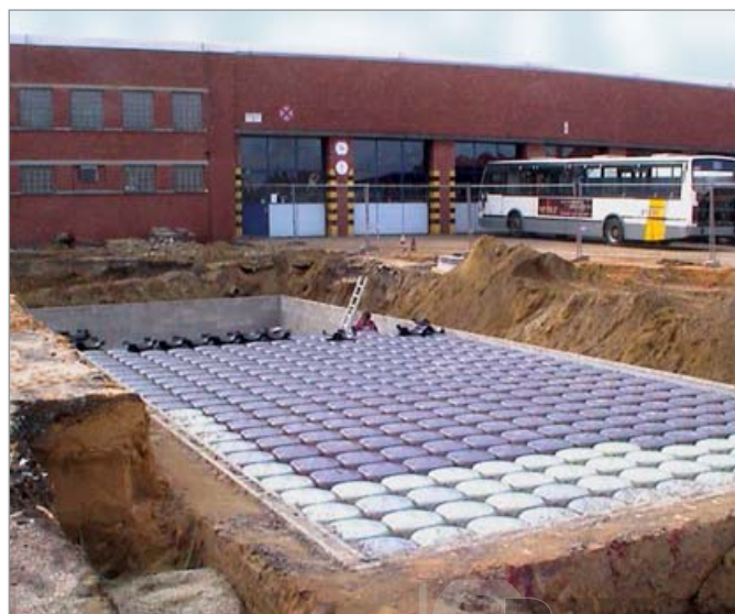
Cistema de recogida debajo de un aparcamiento
