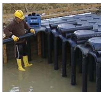
Detalles de la secuencia completa de colocación del Sistema Atlantis.
