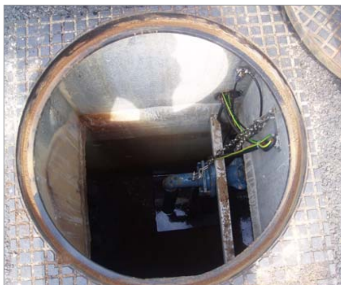
Pocillo de inspección
