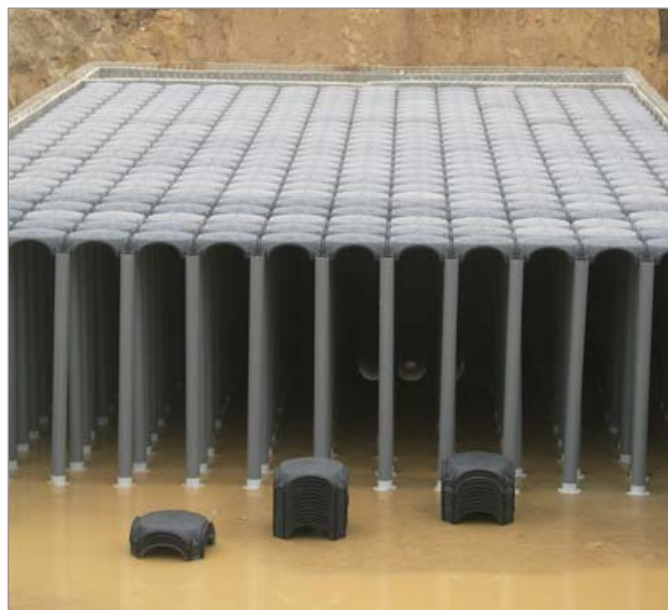
Cistema de recogida agua debajo de una zona industrial
