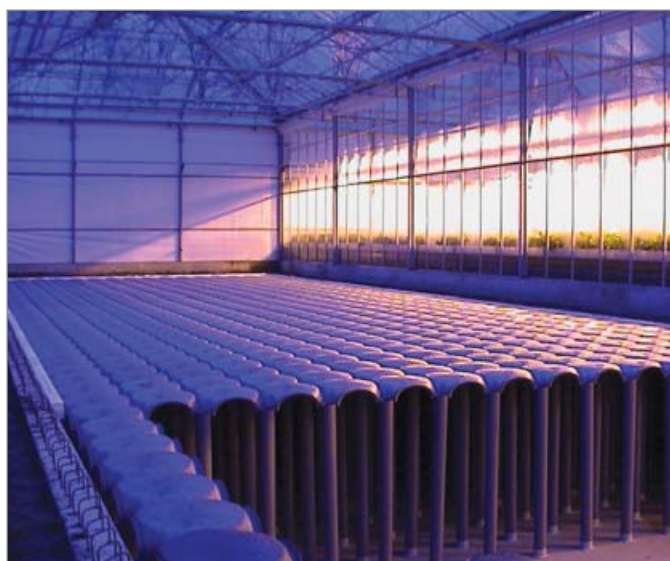
Cisterna de acumulación de agua en un invernadero
