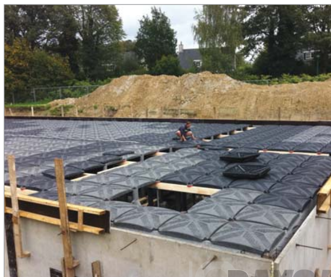
Cisterna de acumulación aguas meteóricas
