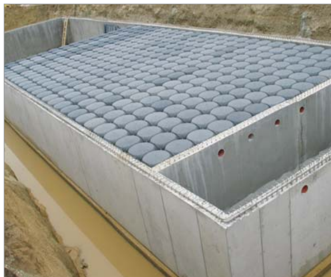
Cistema de recogida agua debajo de una zona industrial
