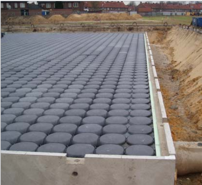
Cisterna de recogida debajo de una zona pensada para el verde
