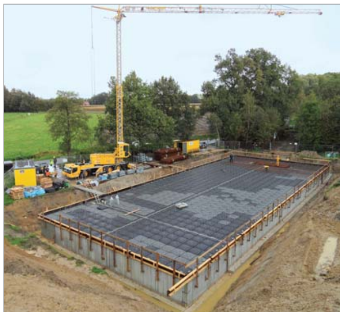
Cisterna de recogida de agua
