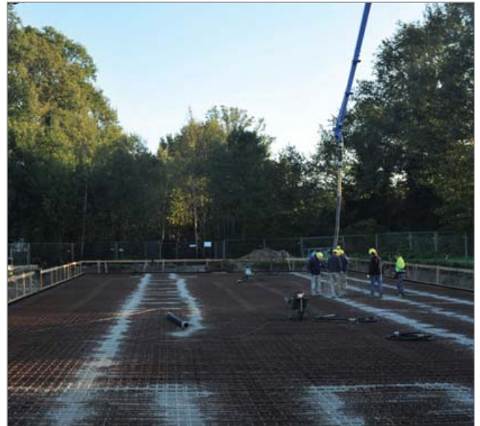
Cisterna de recogida de agua
