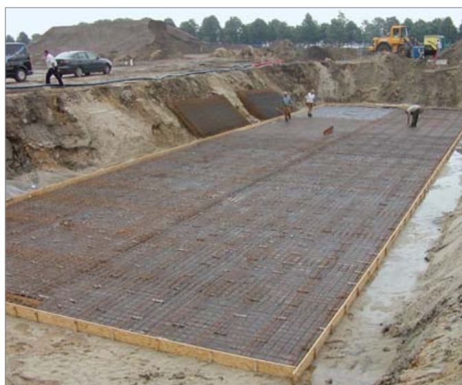
Cisterna de recogida de agua
