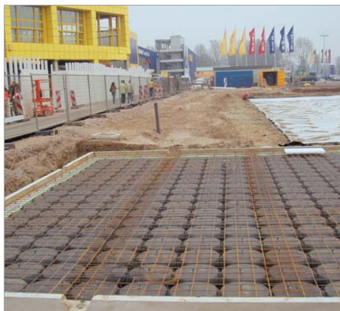
Cisterna de recogida debajo de un aparcamiento comercial
