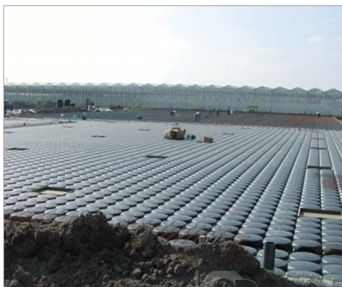
Cisterna de acumulación de agua en un invernadero
