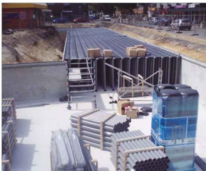
Cistema de recogida debajo de un aparcamiento comercial
