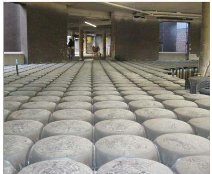
Ampliación Hospital San Gerardo de Monza
