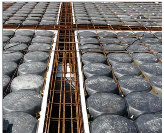
Supersolera - Sistema Atlantis en combinación con Encofrado Pared
