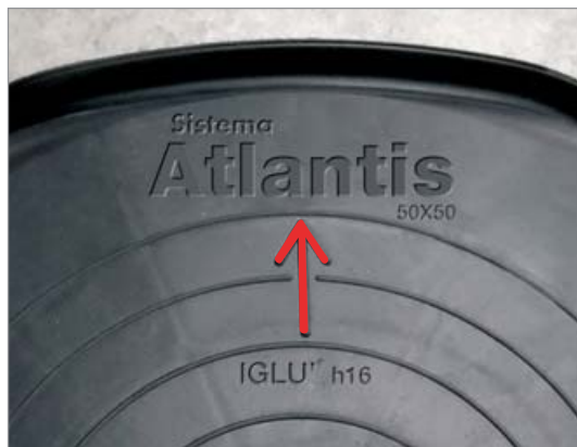
fig. 1 - Colocación en seco del primer encofrado, la flecha está dirigida hacia el cordón de fundación.
