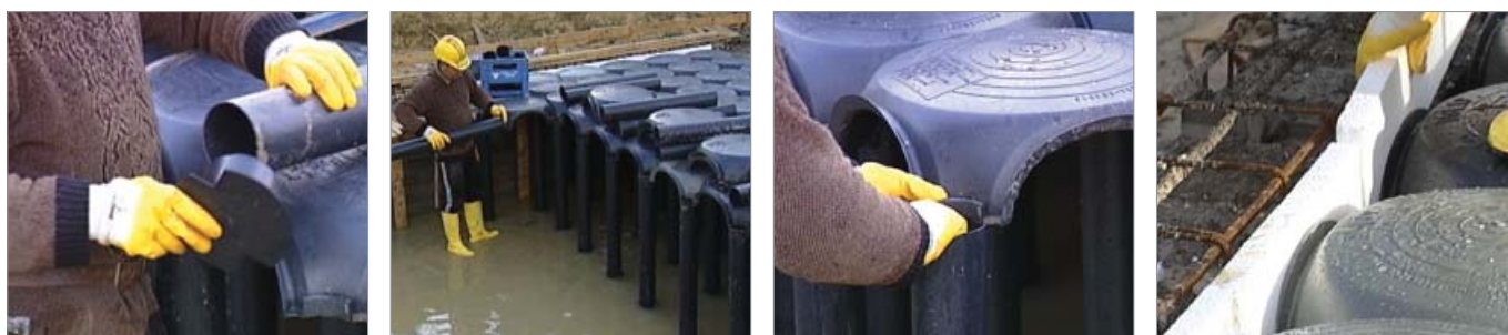
Detalles de la secuencia completa de colocación del Sistema Atlantis.
