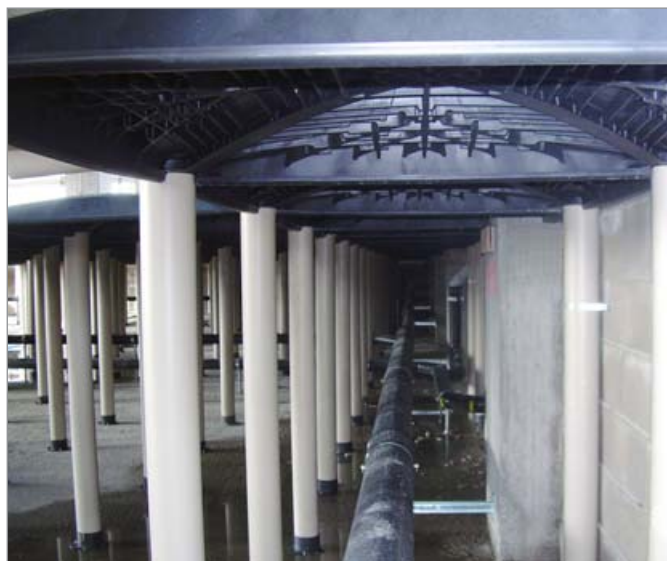
Paso de las instalaciones
