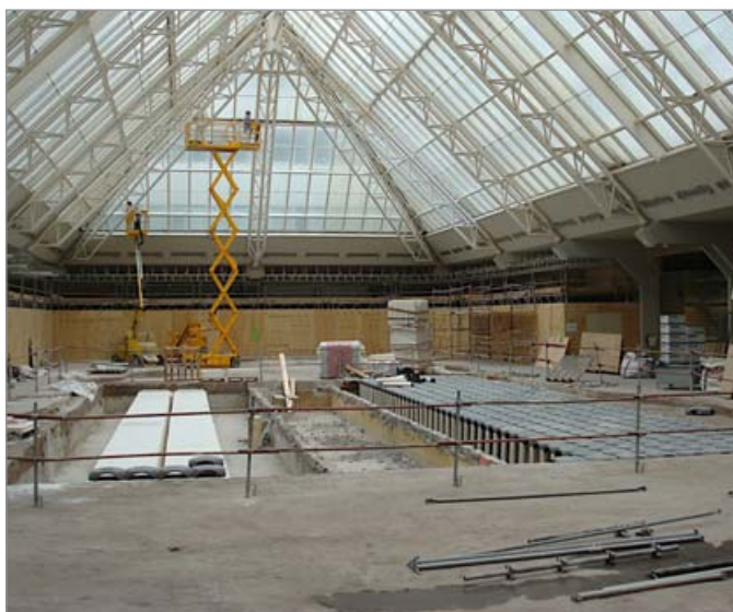
Reforma de piscina
