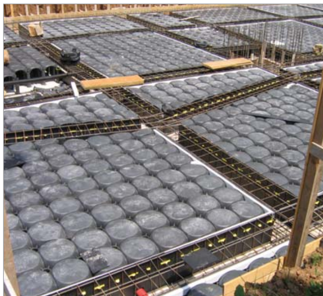
Sistema Atlantis en combinación con Cassaforma Muro
