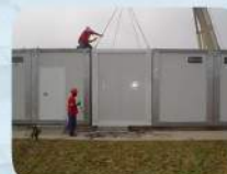
Acoplamiento de Módulos Modules Assembly
