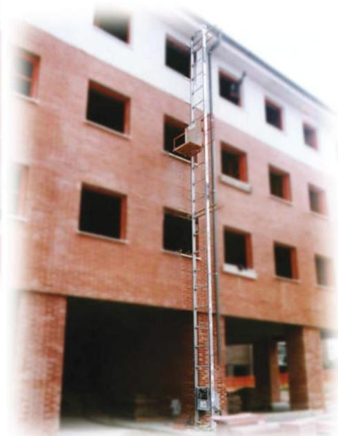
Para la seguridad del personal de la obra, la zona de peligro ha de estar obligatoriamente delimitada por algún dispositivo material mientras se utilizan nuestros montamateriales.
