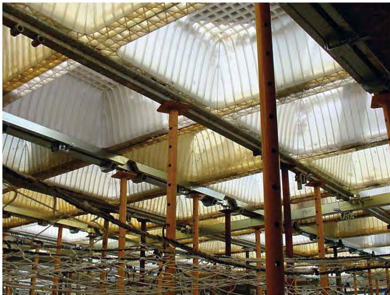
SOPANDEO/PARTIAL RECOVERY/ÉTAYER APRÈS QUITTER LE COFFRAGE ABSTÜTZUNG NACH DEM FRÜHAUSSCHALEN/APPUNTAMENTO PARZIALE
