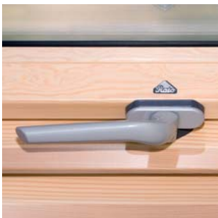
Manecilla situada en el travesaño inferior provista de 1 punto de aireación (posición entreabierta).
