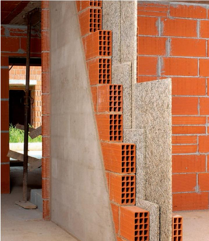
Panel de construcción de viruta de madera de abeto, aglomerado con cemento Portland gris. Entre sus múltiples usos destacamos: eliminación de puentes térmicos en pilares, dinteles, bordones de estructuras...; fondos de radiadores; aislamiento acústico y protección contra el fuego de techos, paredes, pavimentos y encofrados.
