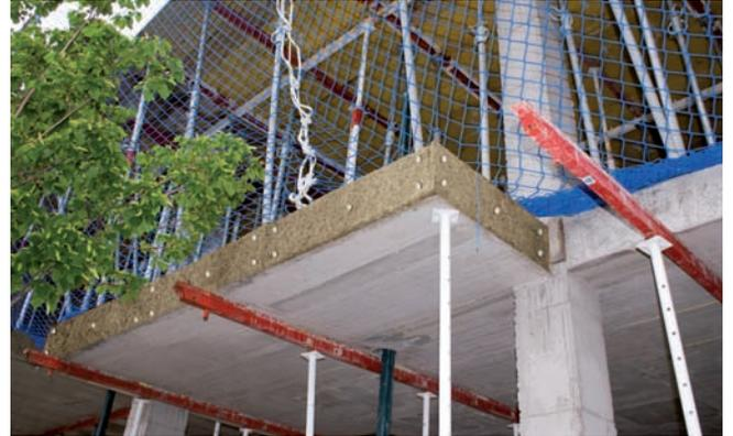
Panel compuesto por un estrato de 10 mm de espesor de viruta gruesa de madera de abeto, aglomerado con cemento Portland gris, firmemente adherido a otro estrato de poliestireno ignífugo. Se usa en el aislamiento de pavimentos, desvanes y tejados; revestimiento aislante y protección contra el fuego de sótanos y pórticos; falsos techos de elevado aislamiento y ligereza; para la eliminación de puentes térmicos en fijación directa con tacos de nylon.
