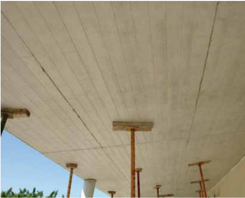
Acabado en hormigón. /Concrete finish.
